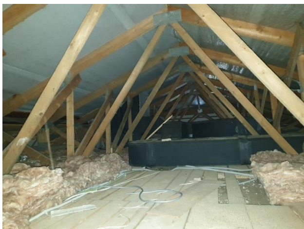
Slika 4: Pogled na obstoječe razvode zraka na podstrešju šole med osema E in D, kjer je razvidno kako zračni kanali vstopajo skozi streho v podstrešje.
