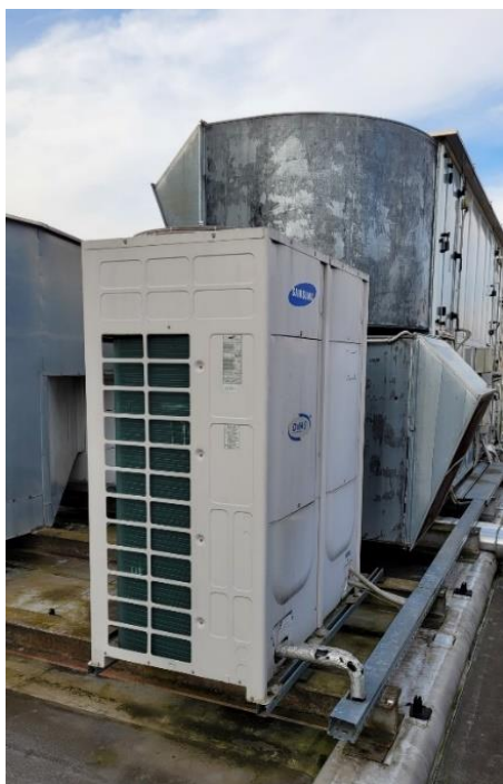
Slika 2: Toplotna črpalka in klimat za hlajenje in ogrevanje zraka OŠ Markovci 11.000 m 3 /h.
