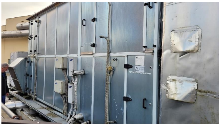
Slika 1: Pogled na klimat za prezračevanje šole postavljen na strehi.
