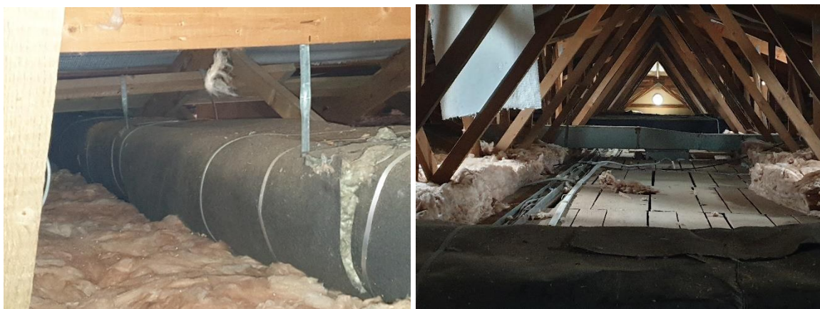
Slika 3: Pogled na obstoječe razvode zraka na podstrešju šole, kjer je razvidno, da je omogočen prehod med posameznimi ostrešji šole.
